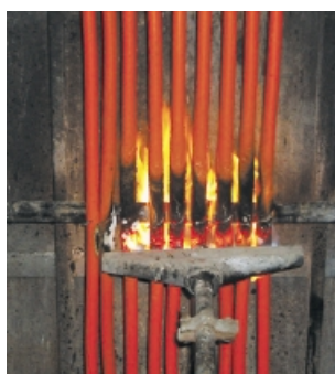
Zkouška vertikálního šíření plamene na vertikálně namontovaných svazcích kabelů a vodičů dle ČSN EN 50266-2-2
